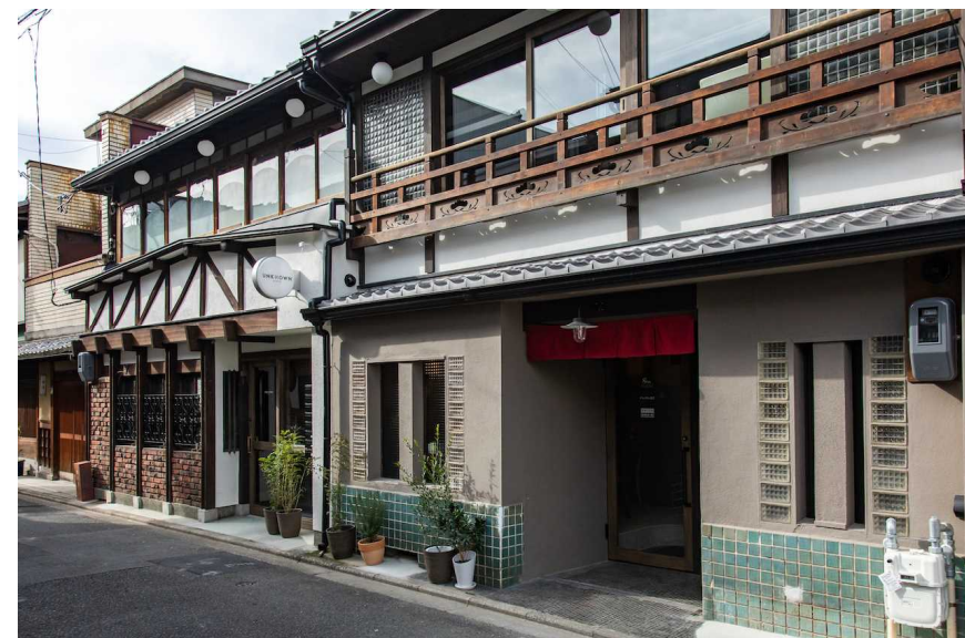
建物外観（改修後）
